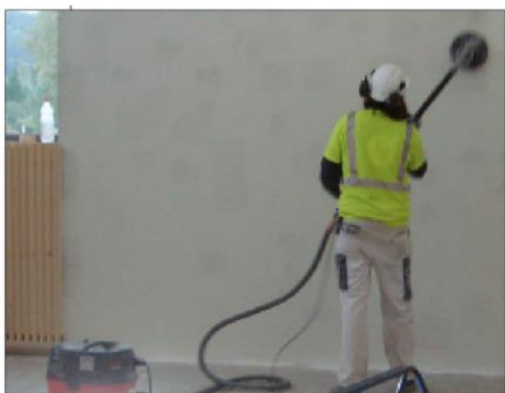
Figur 2: Pussemaskin påmontert støvavsug
